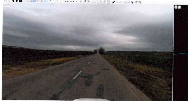
Pod. a příč. trhliny, vysprávk
