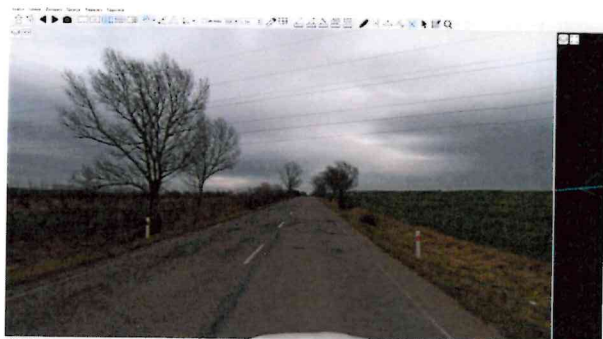
Výtluky, pod. a příč. trhliny, vysprávk
