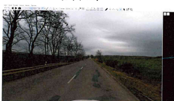
Pod. a příč. trhliny, vysprávk
